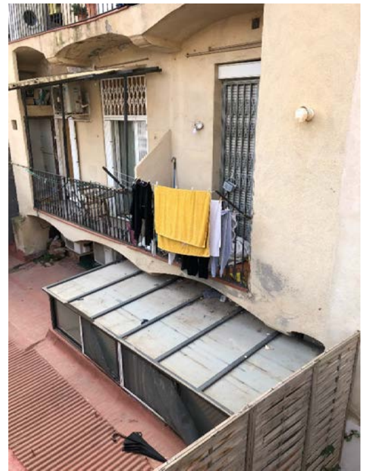
Fotos 5 i 6: Pati posterior del local cobert amb claraboia i tancat lateralment amb fusteria d'alumini
