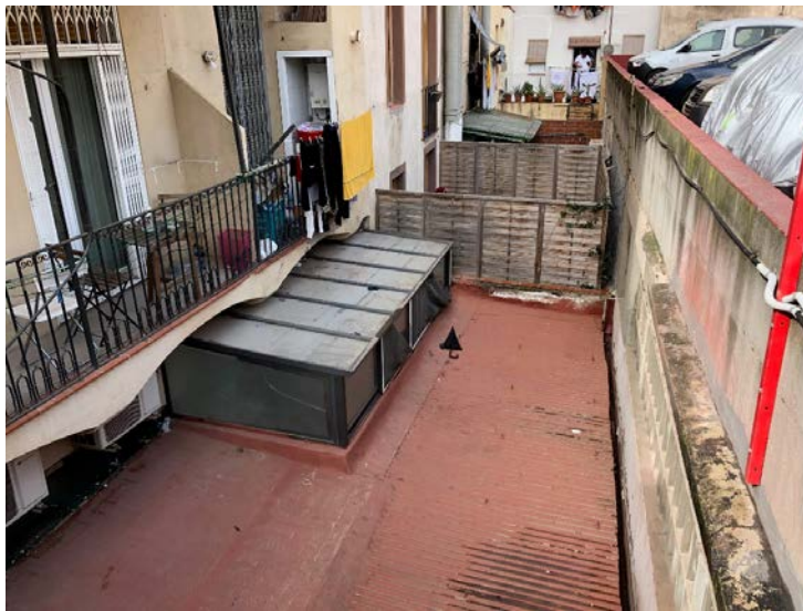
Fotos 5 i 6: Pati posterior del local cobert amb claraboia i tancat lateralment amb fusteria d'alumini
